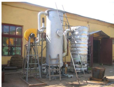
Рис. 2. Вид газогенераторной установки (с теплоизоляцией) с размещением вытяжного вентилятора на разряжение
