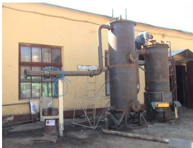
Рис. 1. Вид газогенераторной установки (без теплоизоляции) с размещением вентилятора на наддув
