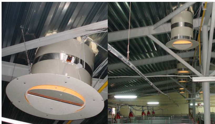
Рисунок 9 – Система вентиляции отрицательного давления с вытяжкой, стеновыми вентиляторами и притоком через пассивные регулируемые крышные каминь
