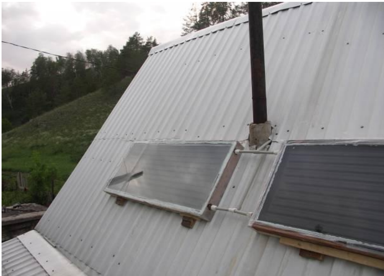
Рисунок 1 – Коллектор солнечной энергии на базе радиатора РСГ
