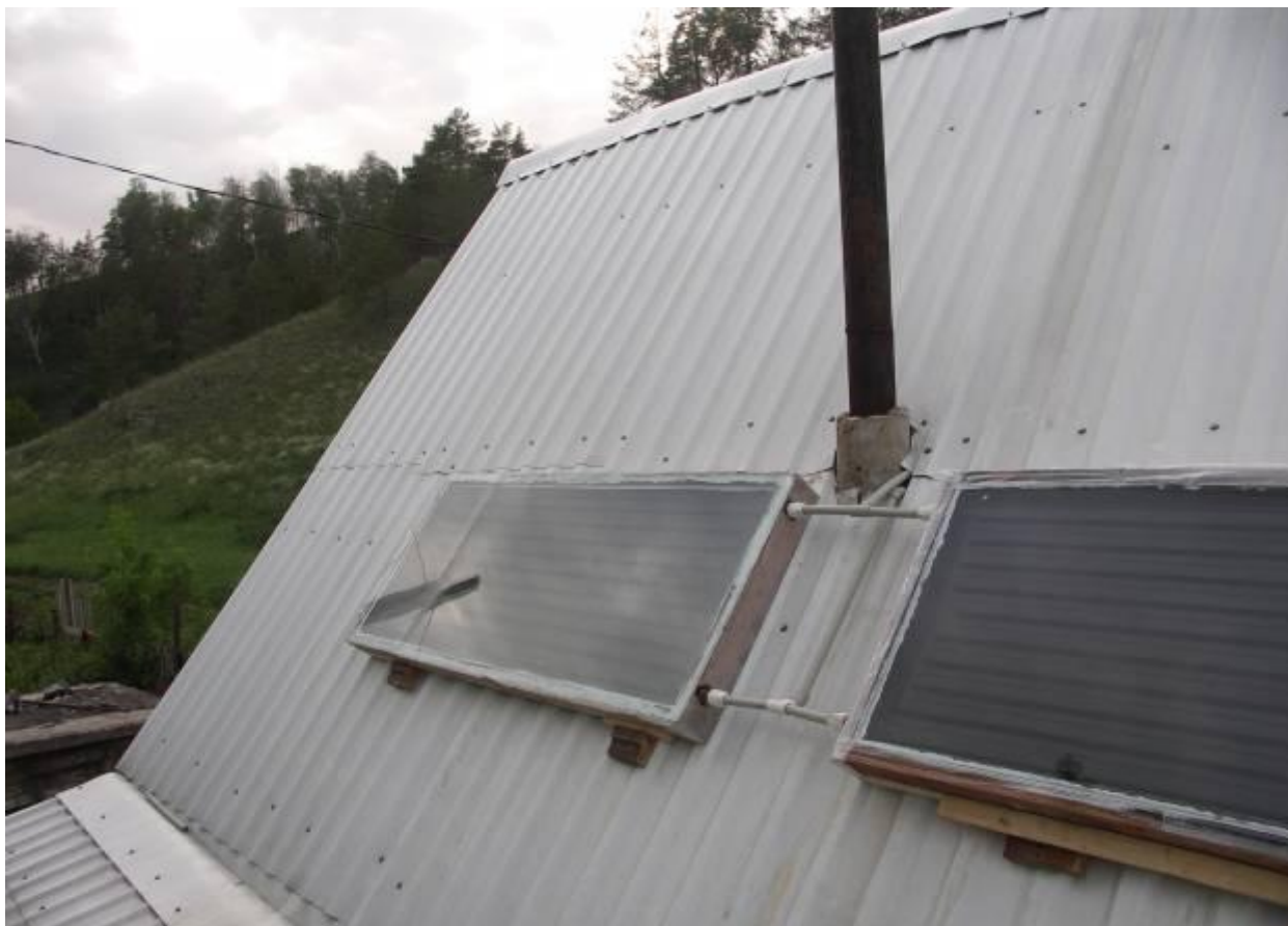
Рисунок 1 – Коллектор солнечной энергии на базе радиатора РСГ
