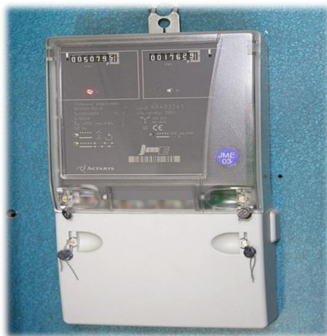
Рисунок 2 – Электронный двухтарифный счетчик
